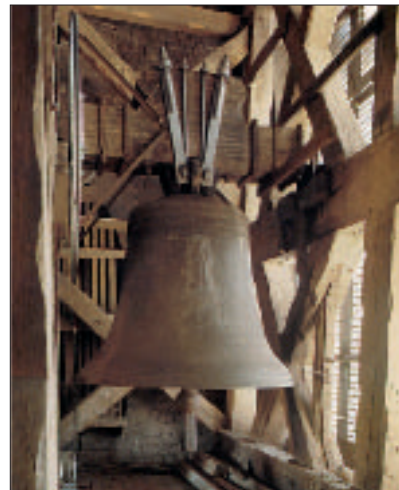
Bild 6: Glocke mit Aufhängebändern am Joch befestigt, links das Läuterad, rechts das Jochlager auf dem Glockenstuhl. Unterhalb der Glocke ist die Läutemaschine im Glockenstuhl integriert.
