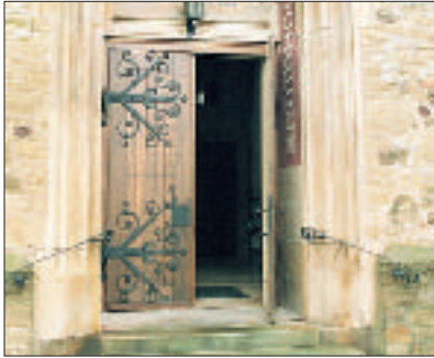
Bild 1: Sichere und tragfähige Zugänge
