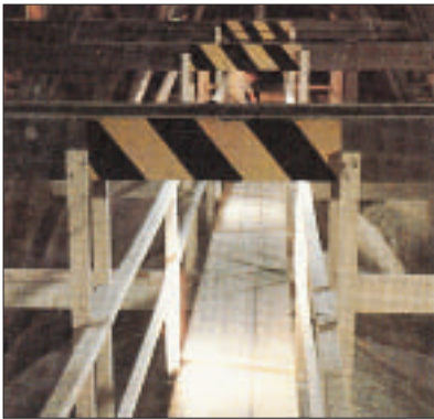
Bild 2: Laufsteg auf einem Kirchenschiffboden
